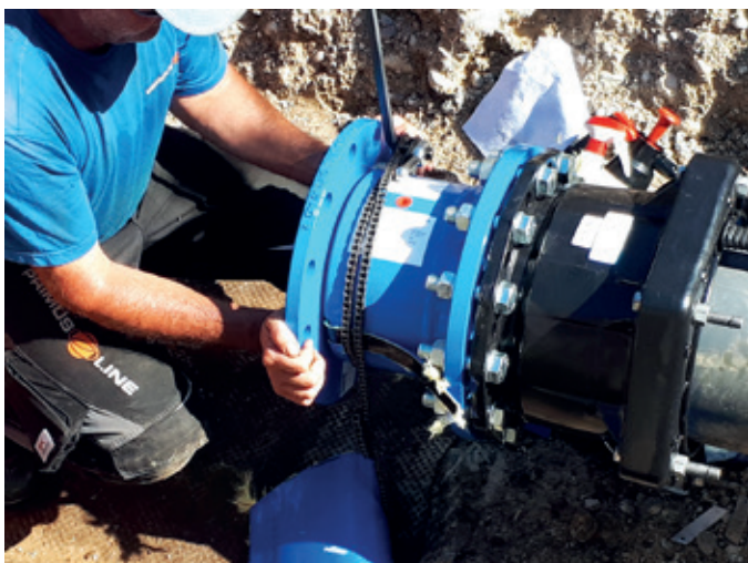
Nach der Montage der Verbinder kann die sanierte Leitung wieder ans Netz.
