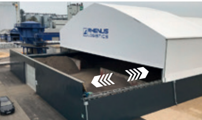
Sonderbauten (z.B. Verschiebbare Dachkonstruktion)
