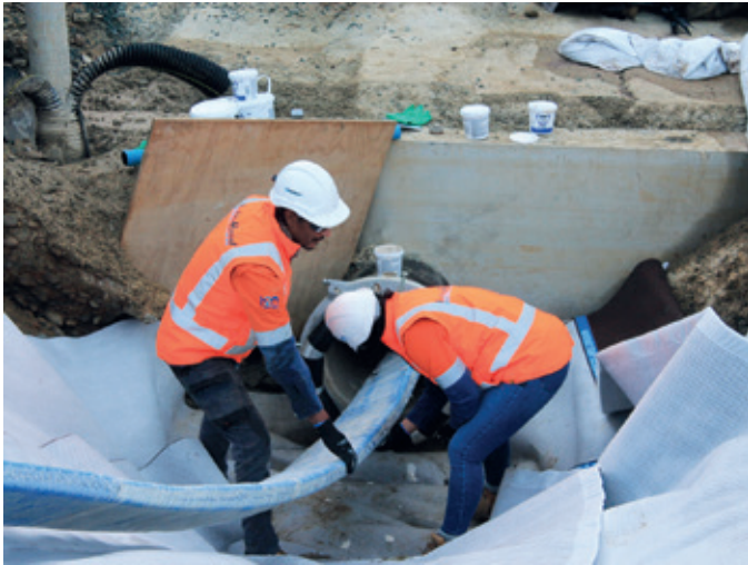
Der Primus Liner kann bis zu einer Länge von 2.500 Metern am Stück eingezogen werden. Dazu ist er U-förmig vorgefaltet.
