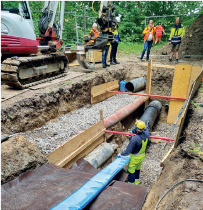
Kleine Baugruben am Start- und Endpunkt dem zu sanierenden Leitungsabschnitts beschränken die Auswirkungen auf die unmittelbare Umgebung auf ein Minimum.
