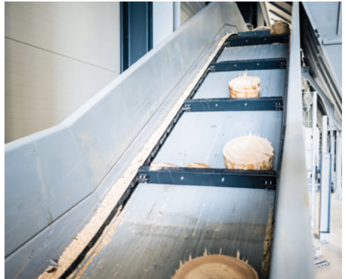
Die Förderanlage transportiert die Kappstücke zum VHZ 1600 zur Vorzerkleinerung.
