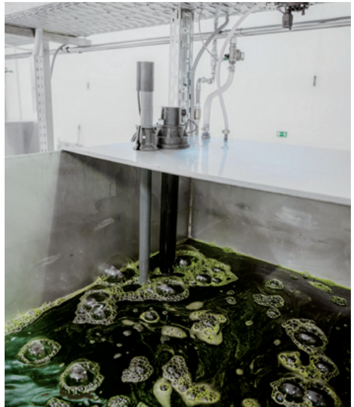
Auslaufbehälter mit Eintaucharmaturen für pH-, Leitfähigkeits- und Trübungsmessung.
