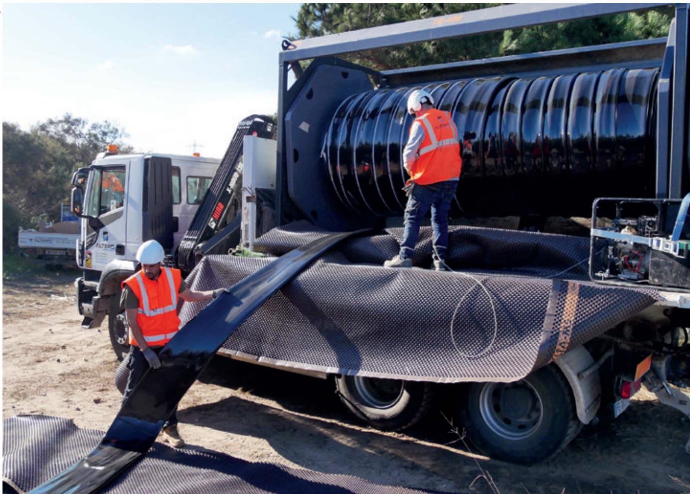
Das flexible Rohr für Primus Line® Overland Piping wird motorgestützt von der Trommel abgerollt.
