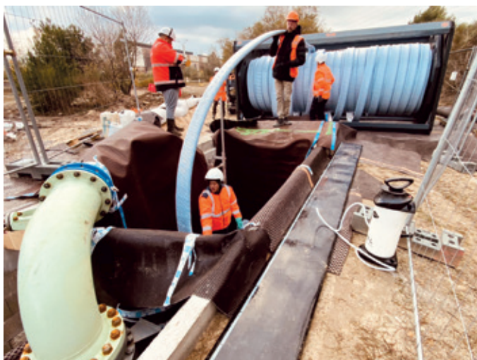
Der Primus Liner zur Sanierung der Sole-Transportleitung läuft von der Trommel in die entsprechende Baugrube. Links im Bild das Verbindungsstück für den Bypass.
