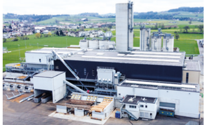
Der Neubau der Tschopp AG: Vecoplan lieferte Anlagen, um die Resthölzer der Sägewerkslinie zu entsorgen und aufzubereiten.
