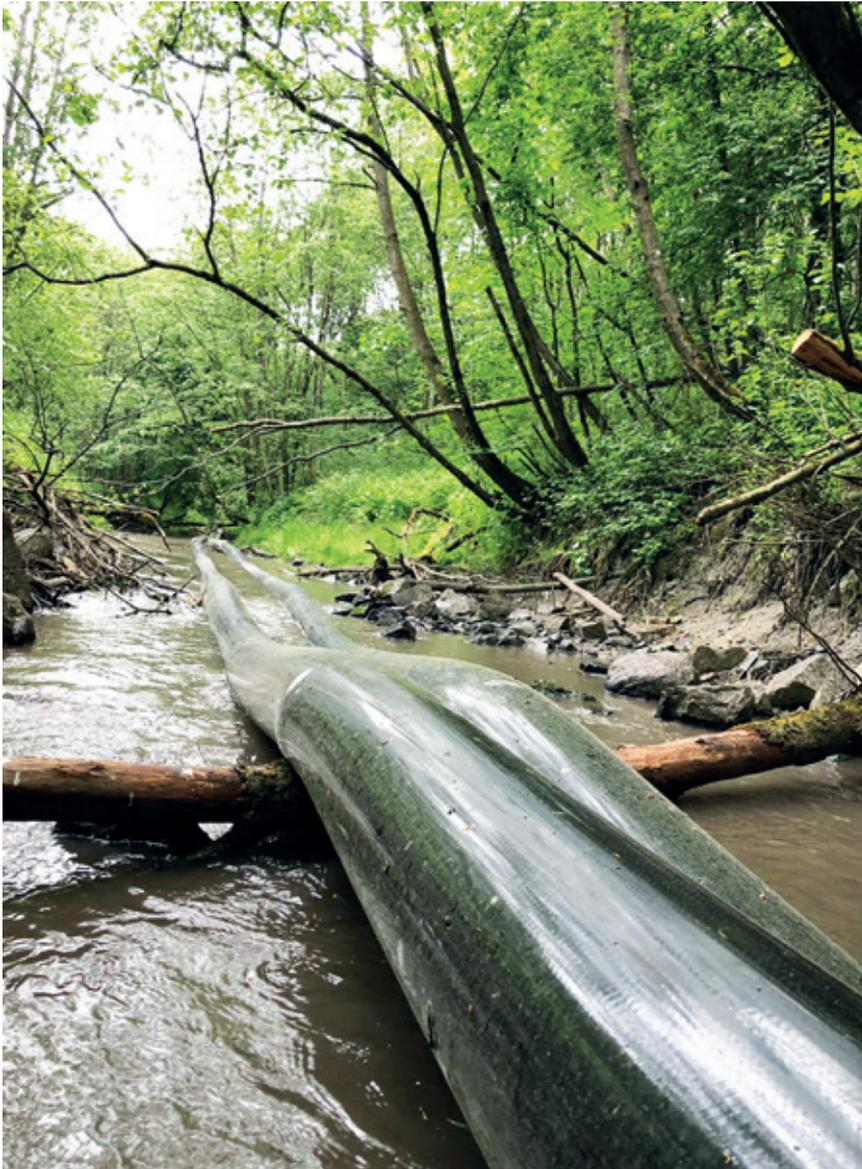
**Gelände-gängig:** Dank seiner **Flexibilität** passt sich **Primus Line® Overland Piping** dem **Untergrund** an.
