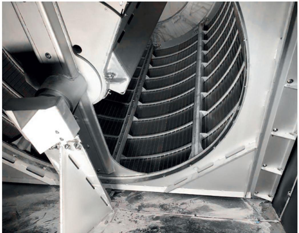
Ein Blick ins Innere der HUBER Siebanlage ROTAMAT® Ro2 2600 XL mit 3 mm Spalt.
