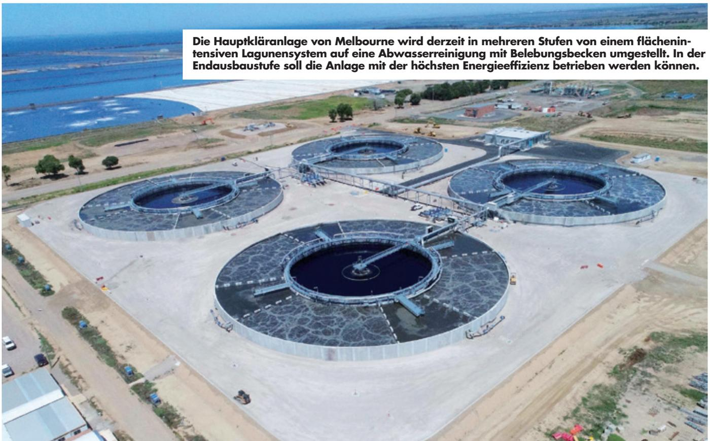
Die Hauptkläranlage von Melbourne wird derzeit in mehreren Stufen von einem flächenintensiven Lagunensystem auf eine Abwasserreinigung mit Belebungsbecken umgestellt. In der Endausbaustufe soll die Anlage mit der höchsten Energieeffizienz betrieben werden können.
